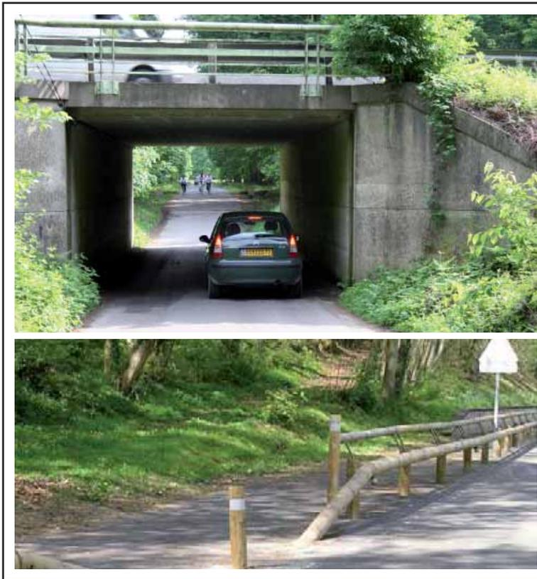
Il est proposé d'isoler, sous le tunnel, un couloir d'1.50 m de large (avec amorces en-deçà et au-delà). Réservé aux piétons, cyclistes (et éventuellement cavaliers), ce couloir les préserverait des voitures : la séparation des circulations étant matérialisée par une glissière / garde-corps de type TERTU (photo du bas).
