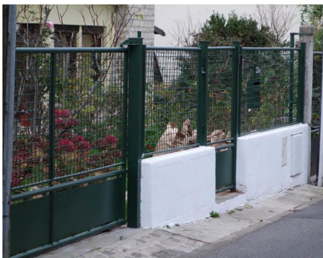
Panneaux de grillage soudé (à maille carrée ou losange, souvent 50 X 50). Ce type de clôture caractérise notamment le quartier des Castors
