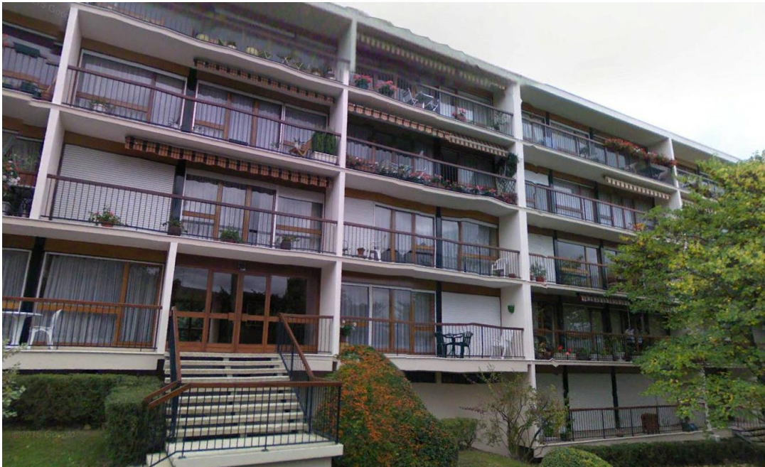
[Le Parc des cascades] - principe de baie continue : la façade ne comporte quasiment plus de surfaces pleines
