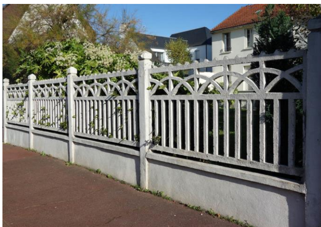
Clôture ajourée en ciment armé. Ces clôtures caractérisent notamment le quartier du Moulin de Senlis (sur une trame le plus souvent carrée).
