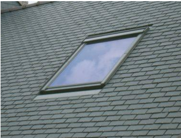
[Châssis de toit encastré dans le pan de la toiture].
