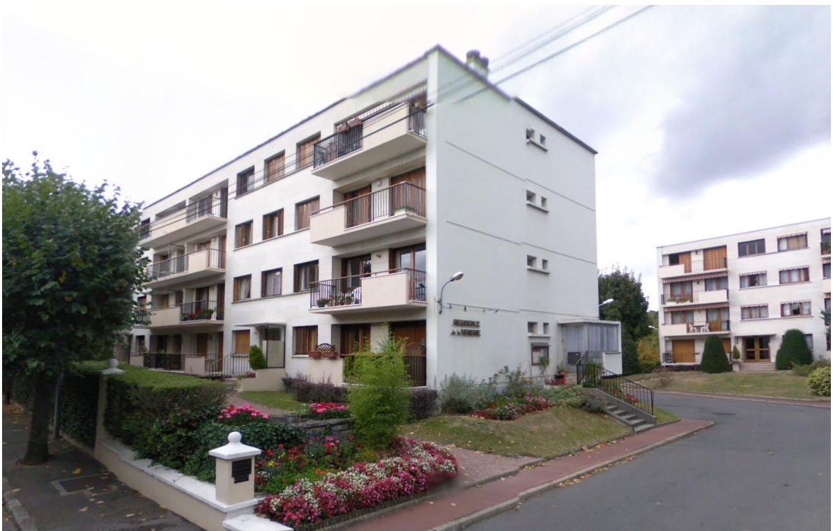
[Le Résidence de la Vénérie] - bâtiments implantés en recul de la rue et isolés les uns des autres, double épaisseur avec circulations centrales et pignons aveugles ; proportions horizontales des fenêtres
