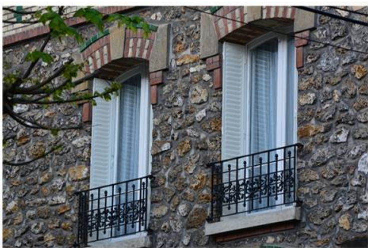
[Volets métalliques persiennés pliants]
