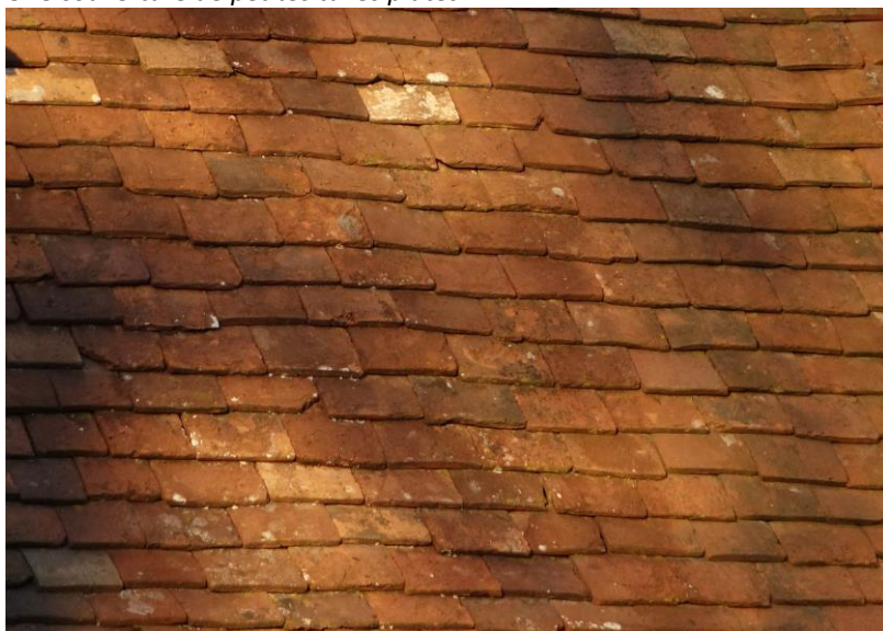
Une couverture ancienne de petites tuiles plates, caractérisée par son irrégularité
