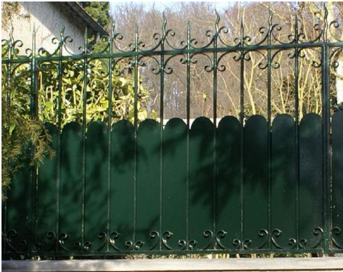
[Grille en barreaudage vertical muni de volutes, occultation par une plaque festonnée situé derrière la grille]
