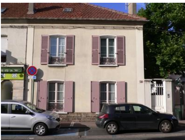
[Façade av. de la République : contrevents pleins au rez-de-chaussée, persiennes à l'étage]
