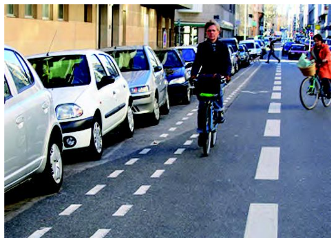
Bande cyclable avec mise en place d'un espace de sécurité entre le stationnement et l'aménagement cyclable
