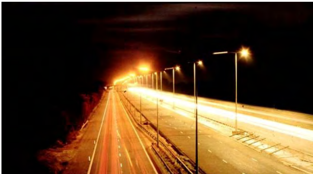
Royaume-Uni, autoroute M5 : modernisation des éclairages avec des luminaires Full Cut Off (à l'avant-plan)
